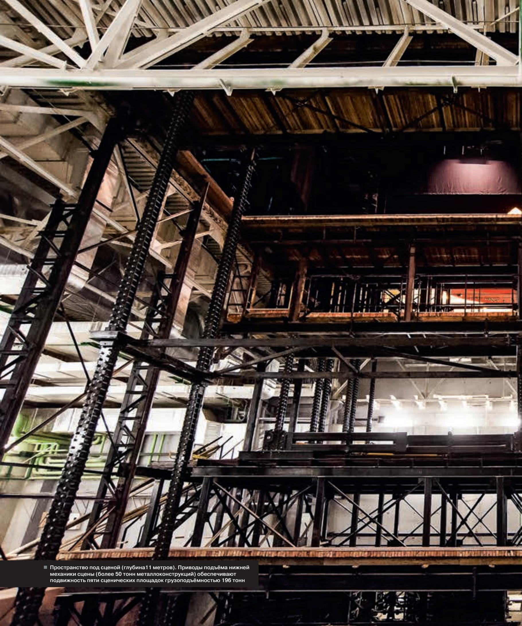
■ Пространство под сценой (глубина 11 метров). Приводы подъема нижней механики сцены (более 50 тонн металлоконструкций) обеспечивают подвижность пяти сценических площадок грузоподъемностью 196 тонн
